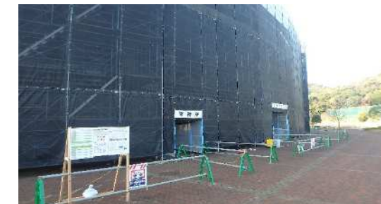
足場養生シートが設置されました
